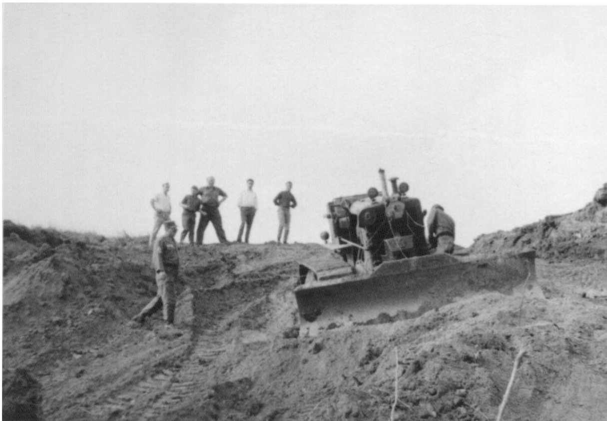
Die Erdarbeiten gehen voran....
