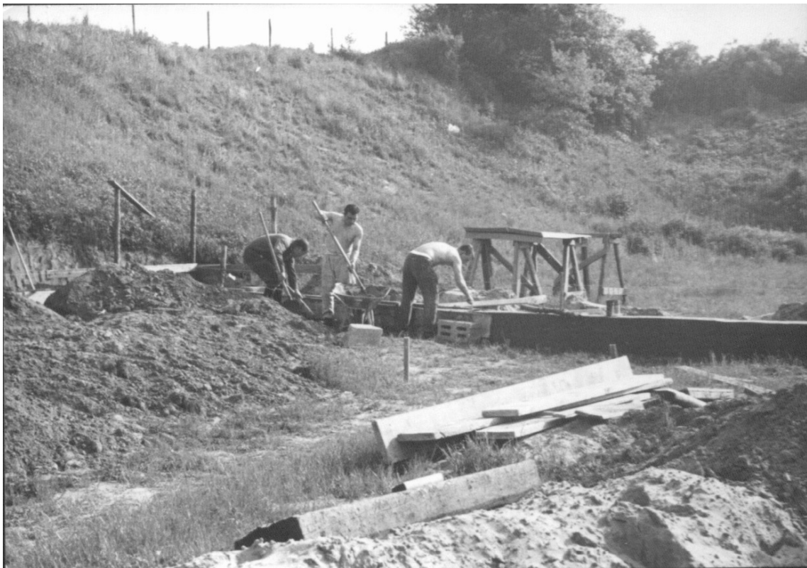
Fundamentlegung und Kanalarbeiten....
