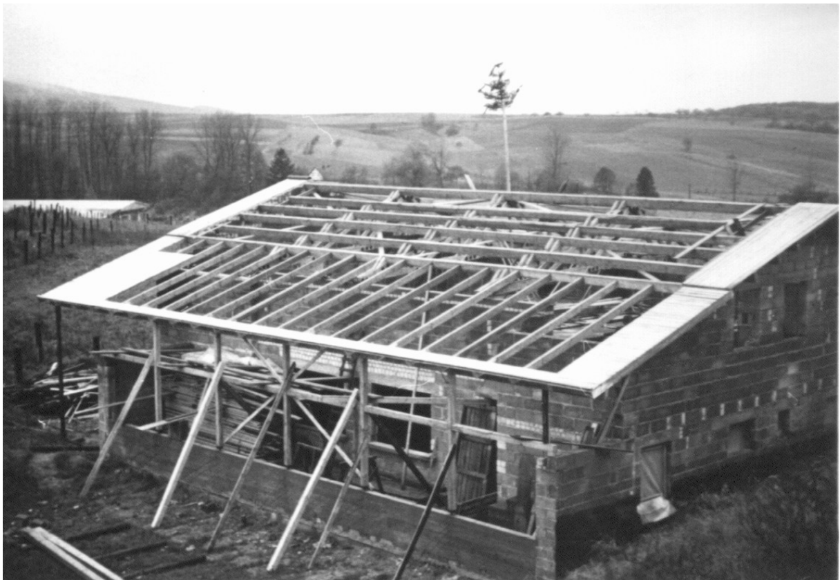
Hinteres Dachgebälk mit Schießstandüberdachung....
